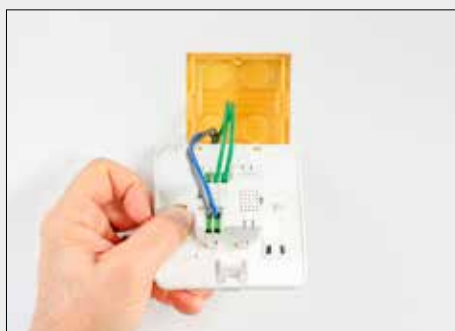
8. Collega ai morsetti 1 e 4 i fili per il rilancio contatti relè.
