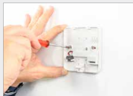
9. Inserisci la piastra completa di alimentatore nella scatola e fissala a parete.
